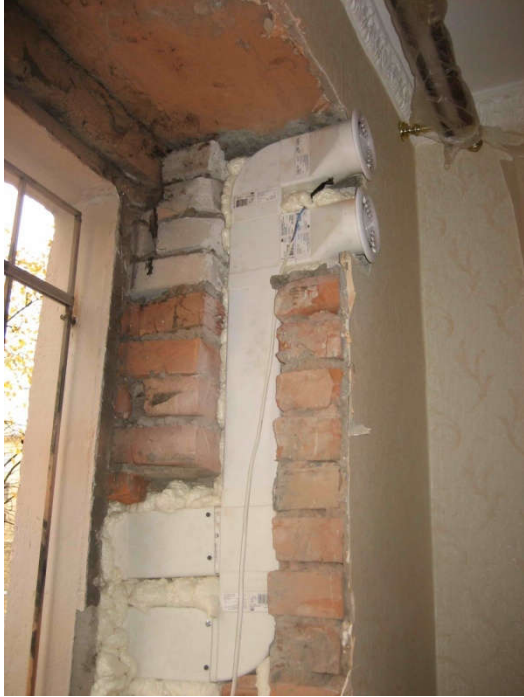
Рис. 3 Рабочий момент скрытой установки ТеФо в нише оконного откоса
