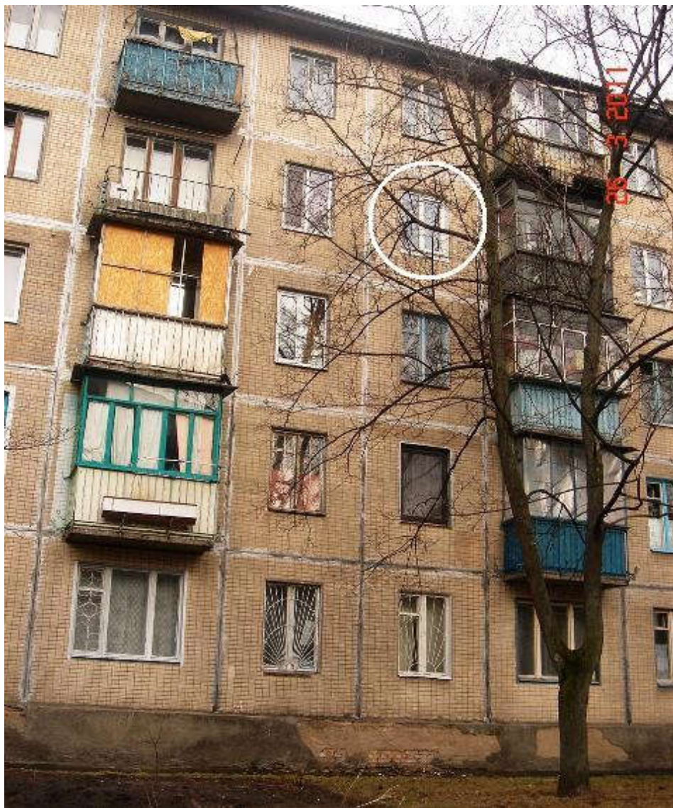
Рис. 8 Фрагмент фасада жилого дома. Окно с функцией рекуперативной вентиляции выделено белым кругом
