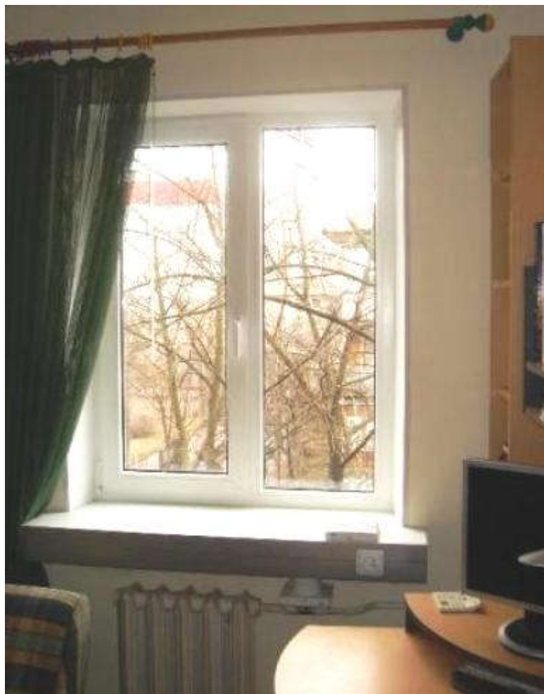
Рис. 6. Интерьер комнаты с теплой форточкой, вмонтированной в подоконник
