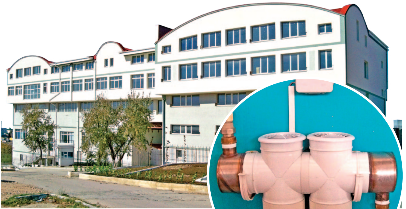
Рис. Пример отопительного прибора с активным и регулируемым съемом теплоты с поверхности. Установлен во всех помещениях административно-производственного здания в Севастополе
