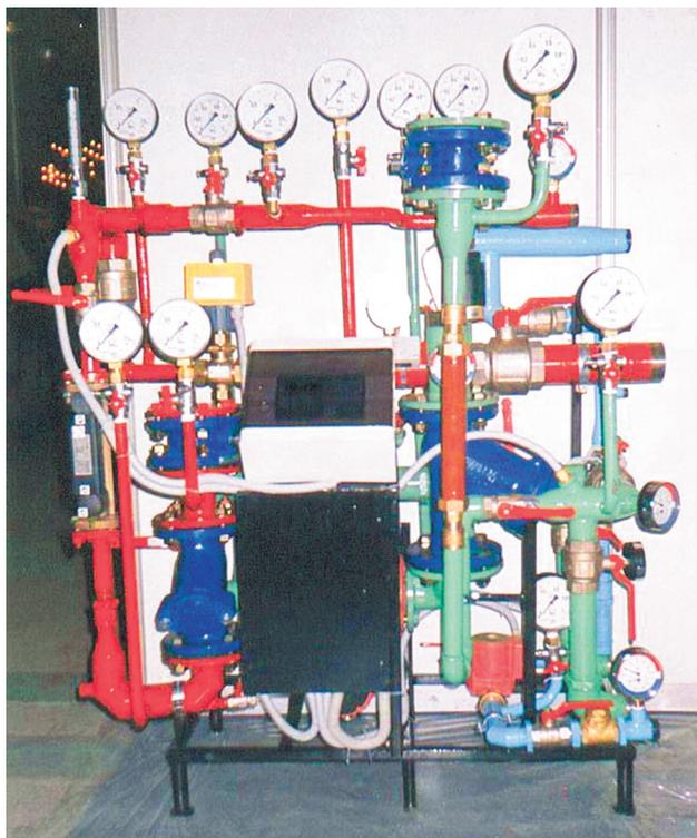
Фото 1. ИТП в виде блок-модуля, созданный с учетом использования теплообменных аппаратов ТТАИ.
