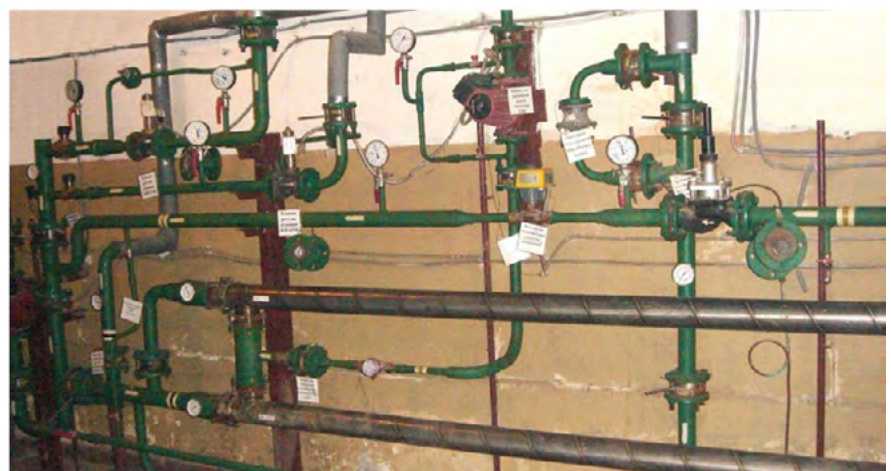
Фото 2. «Планшетный» ИТП размешен в плоскости стены.
